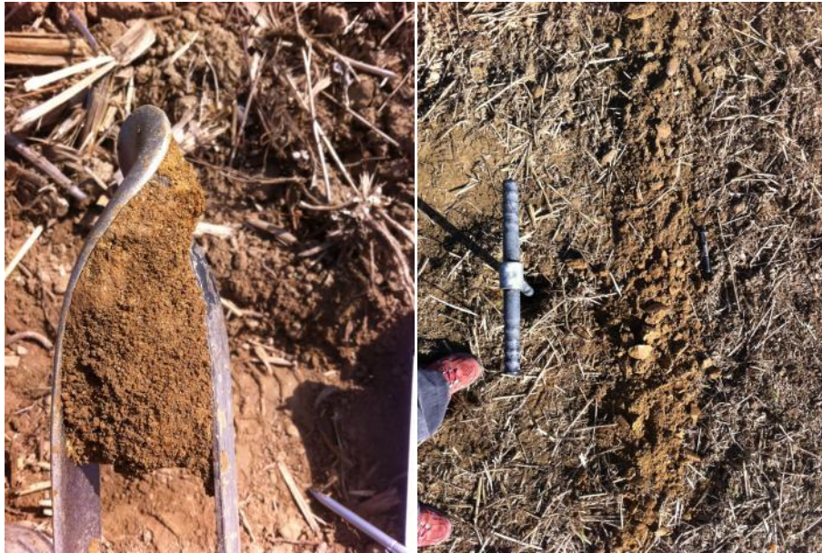
Figure 2-2 : caractérisation visuelle des matériaux
